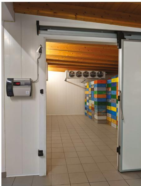
Foto 1. Cella coibentata per la conservazione dei melari a temperatura controllata (foto Lorandi).
