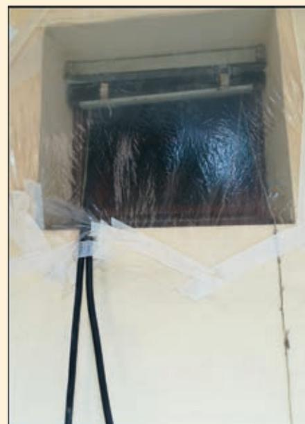
Foto 5. Finestra sigillata con teli in plastica per evitare la dispersione del calore introdotto negli appartamenti con dei tubi in gomma.
